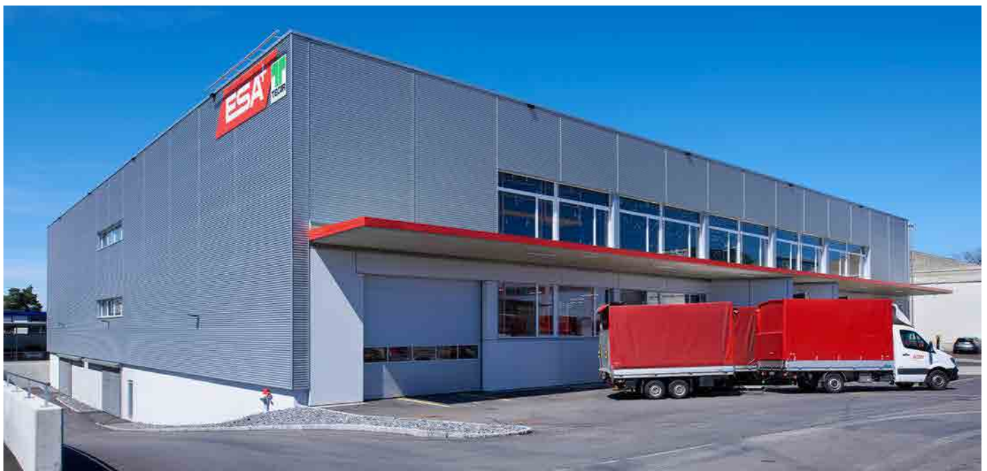
La centrale d'ESA à Berthoud.
