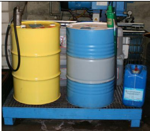
Sonderabfälle in Auffangwannen (Altöle, Bremsflüssigkeiten)
